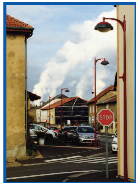
Kuntzig : aménagement de voirie et enfouissement de réseaux rue de la Fontaine Dépense subventionnable : 85 439 € Subvention SISCODIPE : 12 780 €
