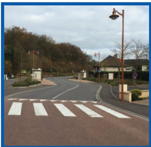
Illange : mise en esthétique des réseaux secs route de Thionville Dépense subventionnable : 152 101 € Subvention SISCODIPE : 22 751 €
